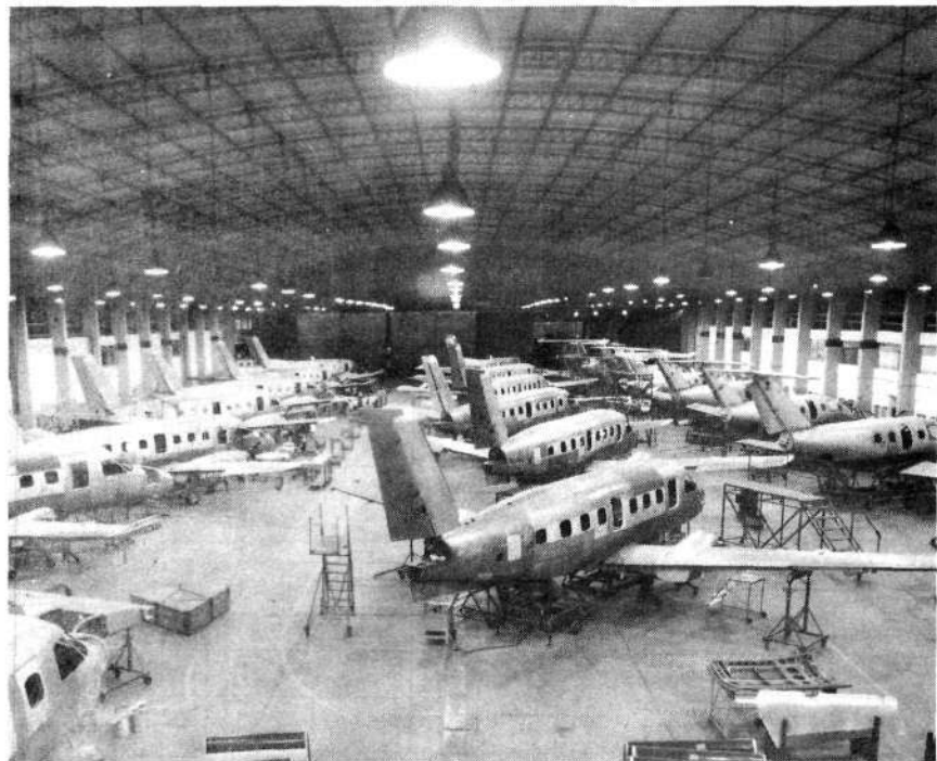
Líneas de producción de los aviones Xingu EMB-121 (a la derecha) y de Bandeirante EMB-110 (al centro y a la izquierda).
